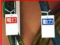
電気の流れを系統表示する表示板
